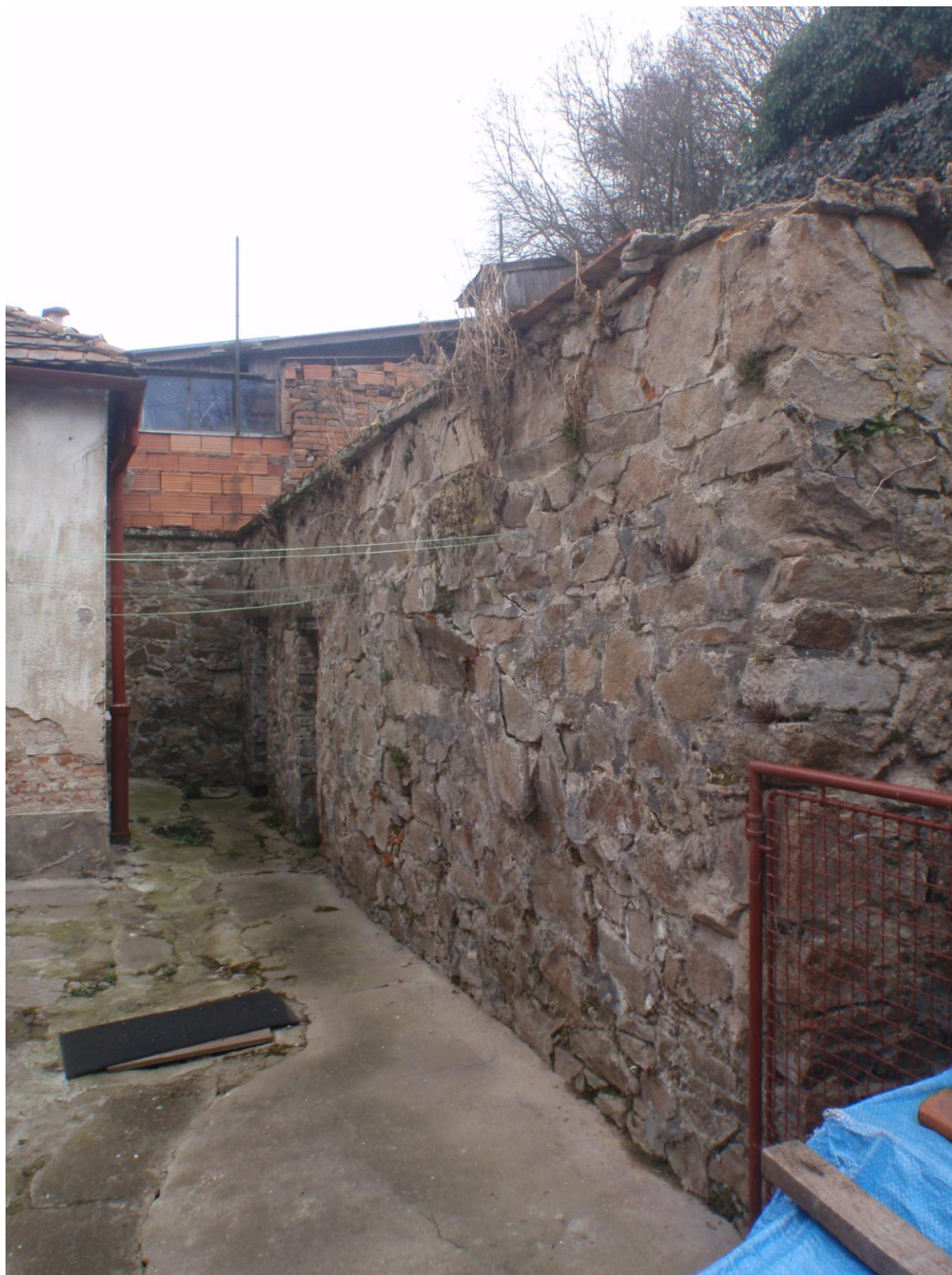
Pohled na řešenou část 1. tarasní zdi za objektem Mlýnská 2 – před dočasným vzepřením opěrné zdi.
