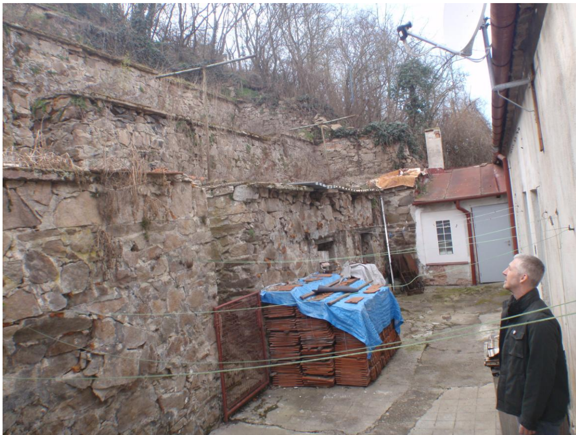
Zed' v řešeném prostoru vykazuje poruchy vážného, až havarijního statického rázu....
