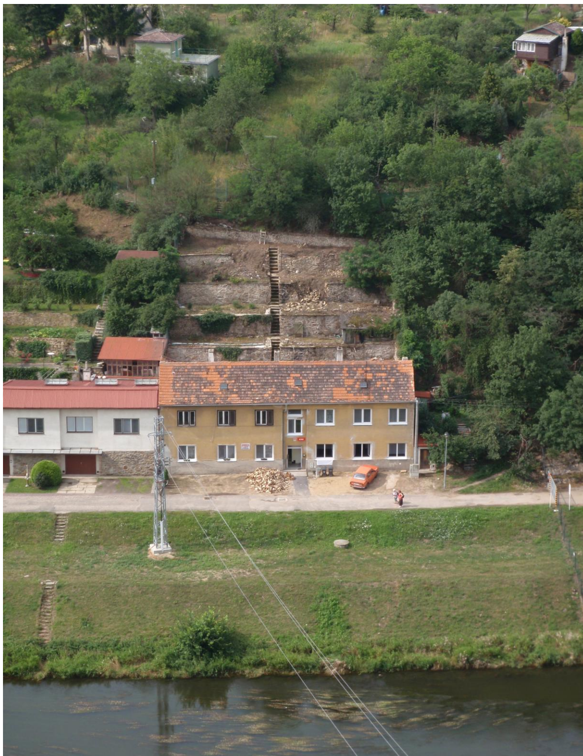
Celkový dálkový pohled na objekt a systém opěrných teras za objektem Mlýnská č. 2. Jedná se o celkově 6 tarasních zdí, v různých výškových úrovních. Zdi se jako celek nacházejí ve staticky nevyhovujícím, místně již havarijním stavu.
