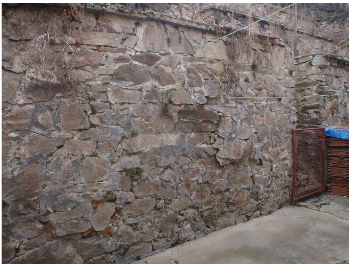
...lokální vyboulení a vybočení tělesa opěrné stěny.
