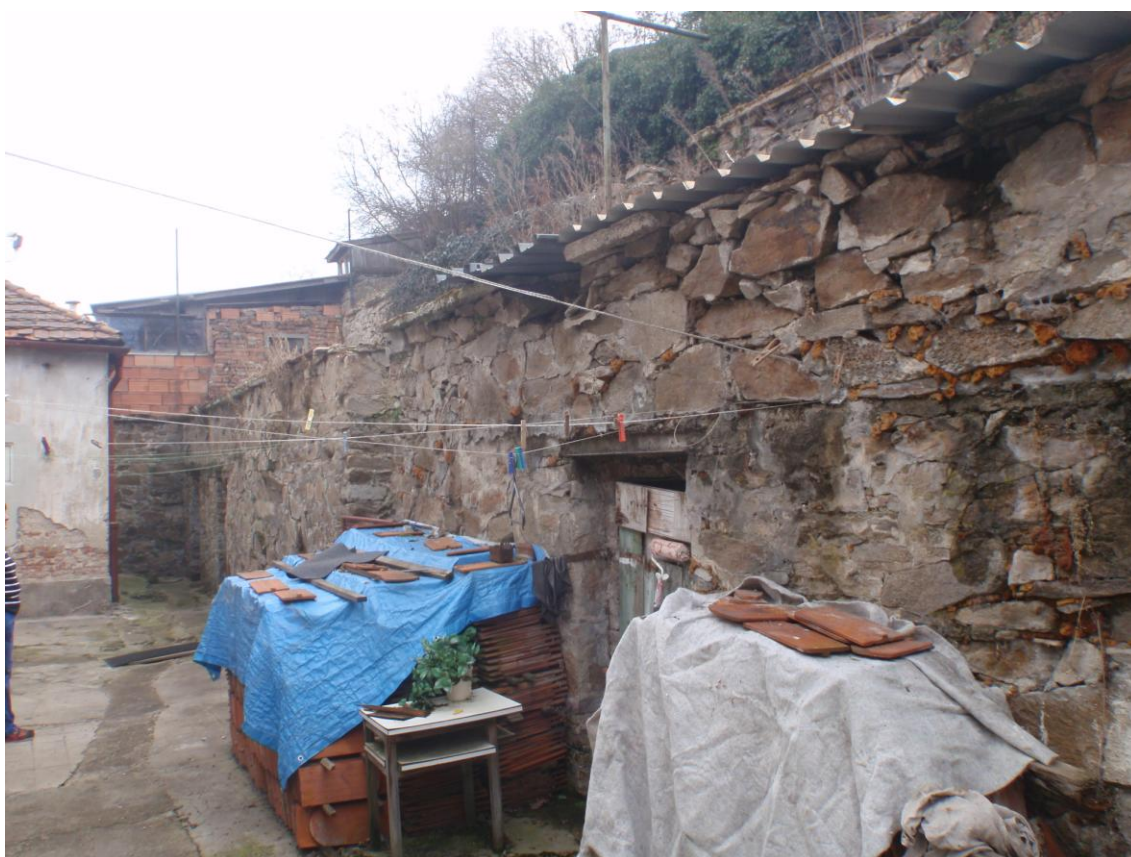
Tyto poruchy jsou způsobeny primárně dlouhodobou absencí údržby stěny a vyplavením pojiva stěny.
