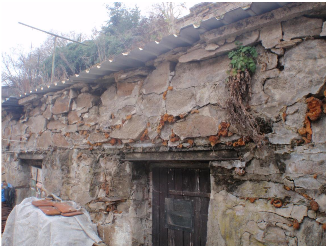
...trhliny v místě nadpraží i dříku stěny....
