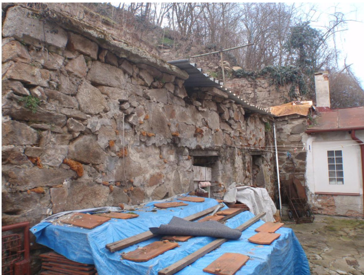
Tyto poruchy jsou způsobeny primárně dlouhodobou absencí údržby stěny a vyplavením pojiva stěny.
